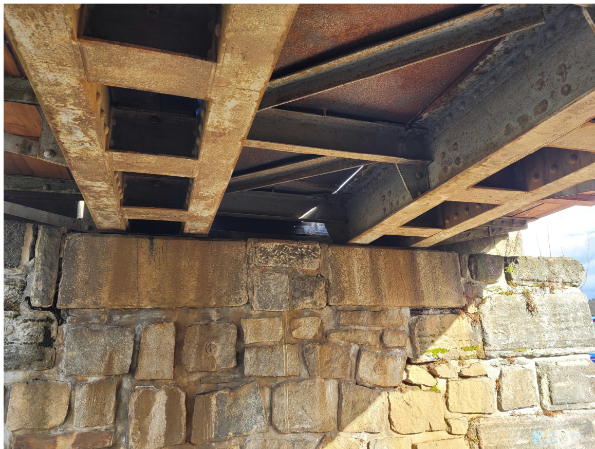
Obrázek 6: pohled na opěru O02 (uložení)
